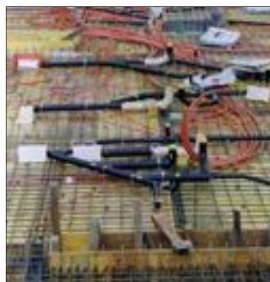
Трубопровод, заделываемый в бетон
